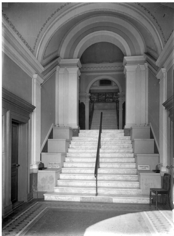
Trapperummet i den gamle museumsbygning.
